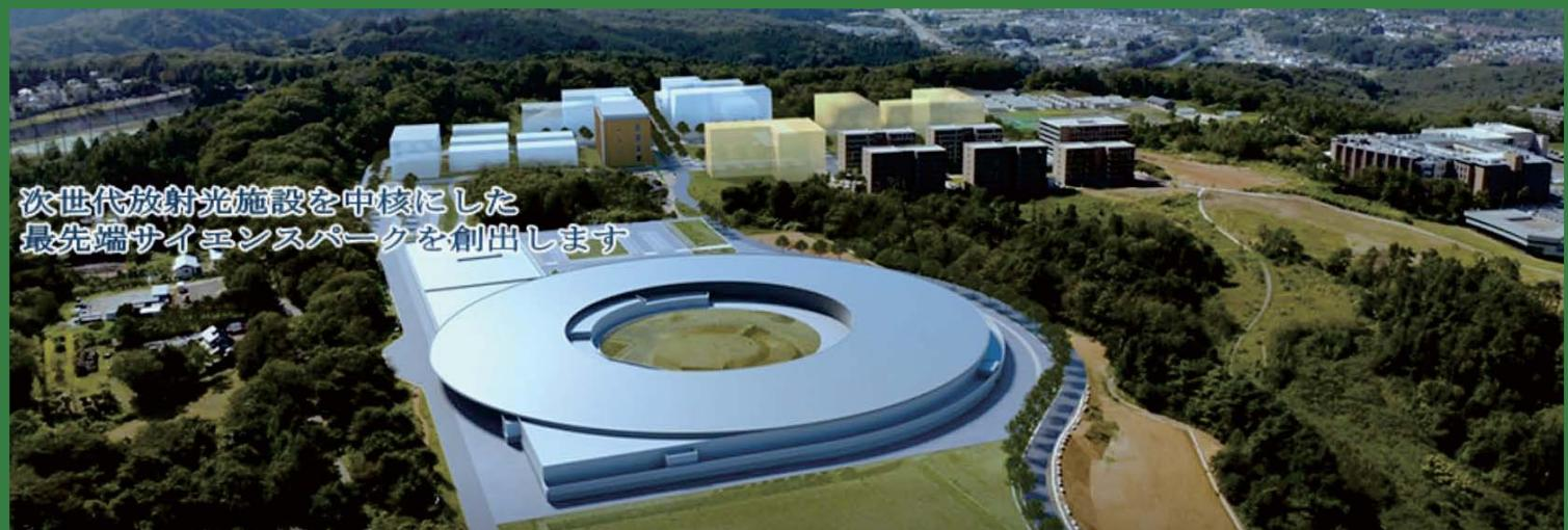
1nm・mradという世界最高クラスのエミッタنسをもつ次世代放射光源が2023年の完成に向けて、現在仙台市に建設中です。世界最大規模のSPring-8は硬X線領域の放射光源ですが、本次世代光源は軟X線領域にピークをもつ高輝度のX線が利用可能で、イメージング、時分割測定などこれまでと次元の違う新しい分析手段を提供することが期待されます。次世代DX技術を用いたデータ取得、データ蓄積、データ処理が計画されています。本施設では、従来の放射光とは異なるコアリッシュンという新しい方式で、マシンタイム配分が行われます。北大もこの新しい放射光施設を東北大学と連携し進め、利活用して、物質材料、物性、生命、医学、農学研究に生かすことが計画されています。このたび、放射光施設を建設・運営する東北大SRIS (International Center for Synchrotron Radiation Innovation Smart) の村松淳司センター長をはじめSRISの先生に概要をご説明いただき、質疑の時間を設けたいと思います。
